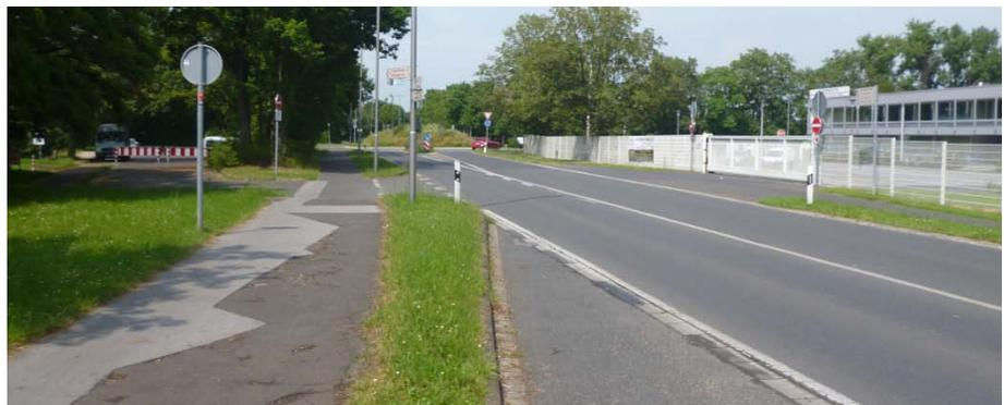
*Abbildung 7-23: Querungsbedarf des links abbiegenden Radverkehrs am Fuß-/Radweg Richtung Baumberg ist nicht gesichert*
