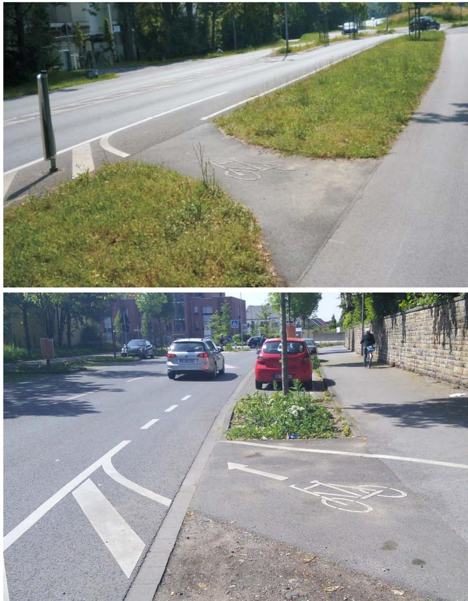
*Abbildung 7-12: bauliche Überführung des Radverkehrs aus dem Seitenraum auf die Fahrbahn vor dem Kreisverkehr innerorts mit Optimierungsbedarf*
